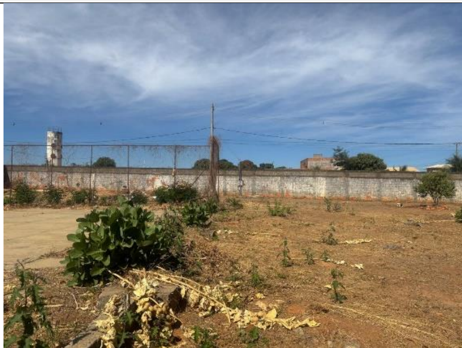
03 – LOCAL DE CONSTRUÇÃO DA QUADRA
