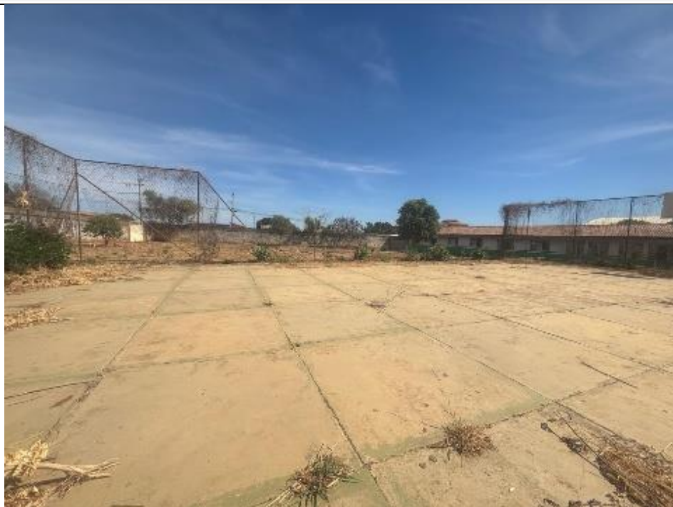
01 – PISO QUADRA ANTIGA À SER DEMOLIDO
