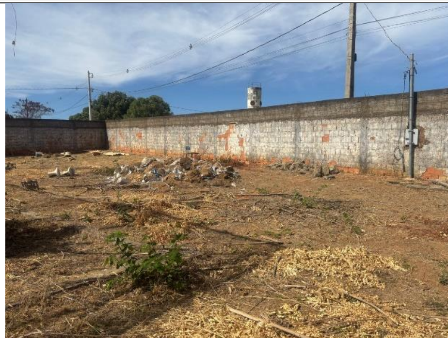
04 – LOCAL DE CONSTRUÇÃO DA QUADRA
