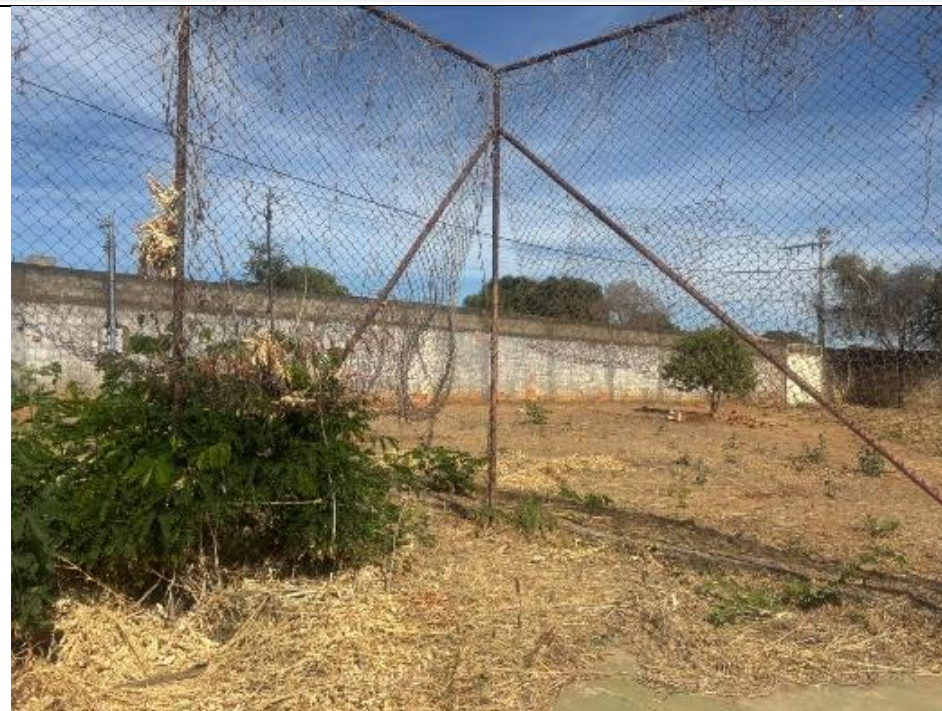
02 – ALAMBRADO A SER DEMOLIDO
